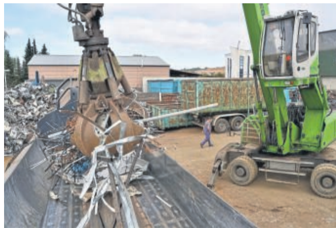
Raubtierfütterung: Mit einem Umschlagbagger befüllt Jens Strohm den Presskasten der neuen Schrottschere.
